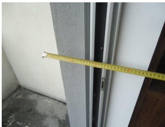
Figura 4 – Medição no local (espessura medida 35cm).
