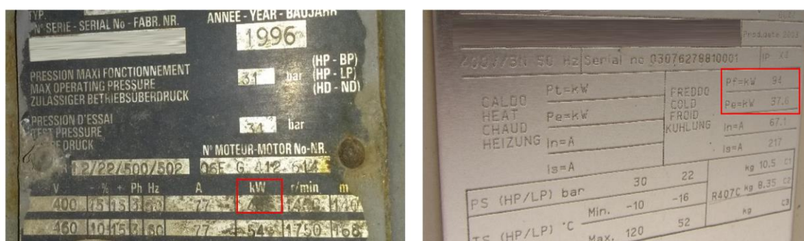
Figura 29 – Chapas de características típicas de “Chillers” só frio.
