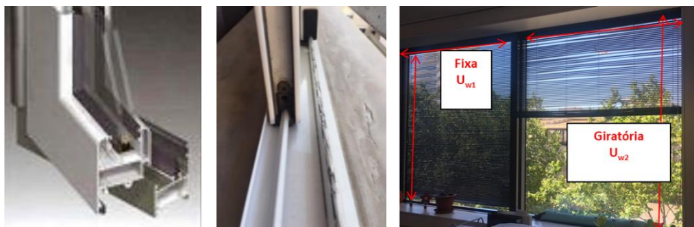
Figura 8 – Janela com caixilho de metal sem corte térmico.
