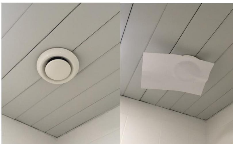
Figura 41 – Verificação de funcionamento do ventilador: extração permanente.
