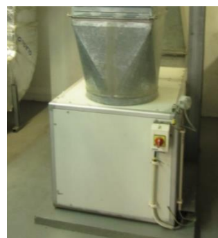
Figura 42 – Ventilador e respetiva chapa de características técnicas.
