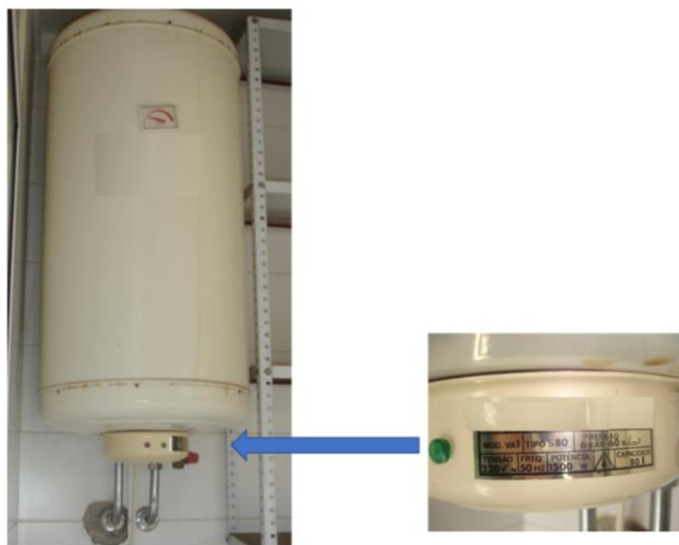
Figura 17 – Termoacumulador e respetiva chapa de características técnicas.
