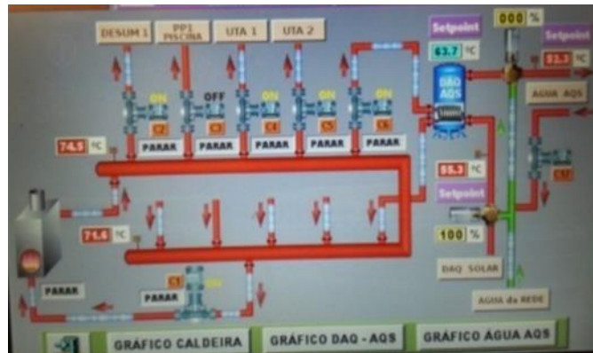
Figura 70 – Interface de um sistema de gestão da produção de água quente.
