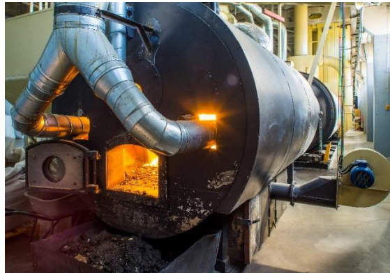
Figura 37 – Sistemas de produção de energia renovável: Aquecimento a Biomassa.
