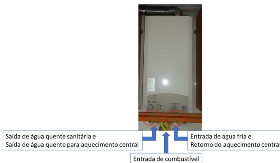
Figura 20 – Identificação das ligações de uma caldeira do tipo mural.
