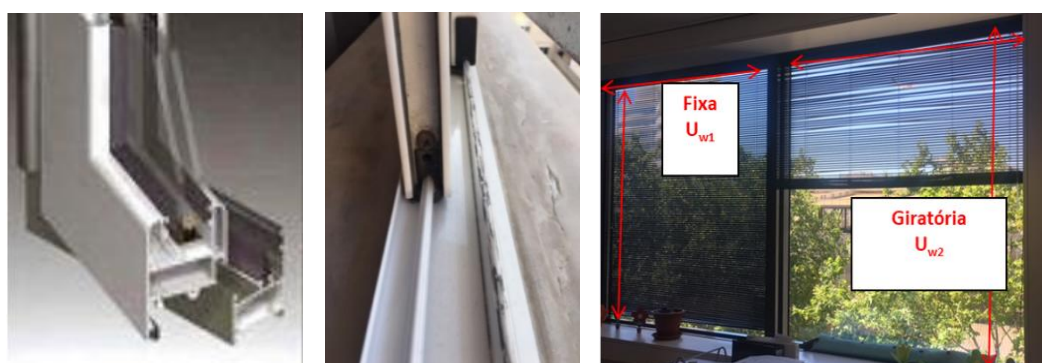
Figura 9 – Janela com caixilho de metal com corte térmico.
