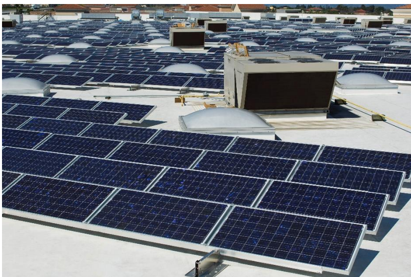
Figura 40 – Sistema solar fotovoltaico.
