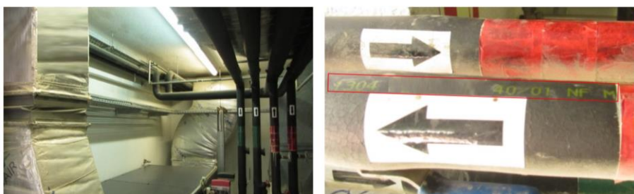
Figura 53 – Sistemas de tubagens e condutas.
