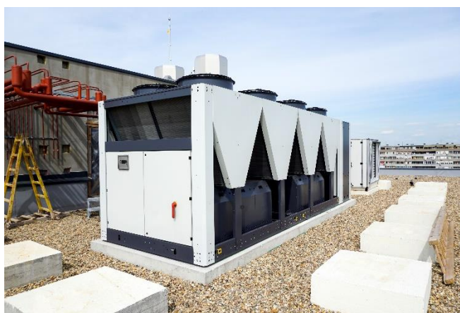
Figura 27 – Unidade de produção de água de frio e quente do tipo “Chiller”.
