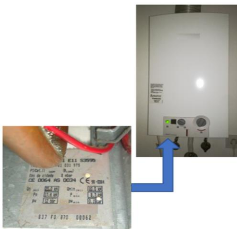
Figura 14 – Esquentador e respetiva chapa de características técnicas.
