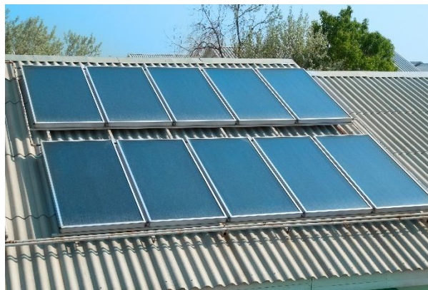
Figura 39 – Sistema solar térmico.
