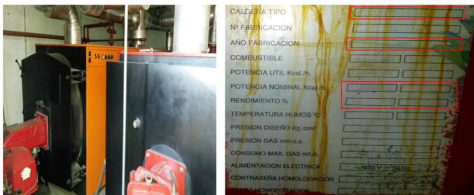
Figura 22 – Caldeira e respetiva chapa de características técnicas.
