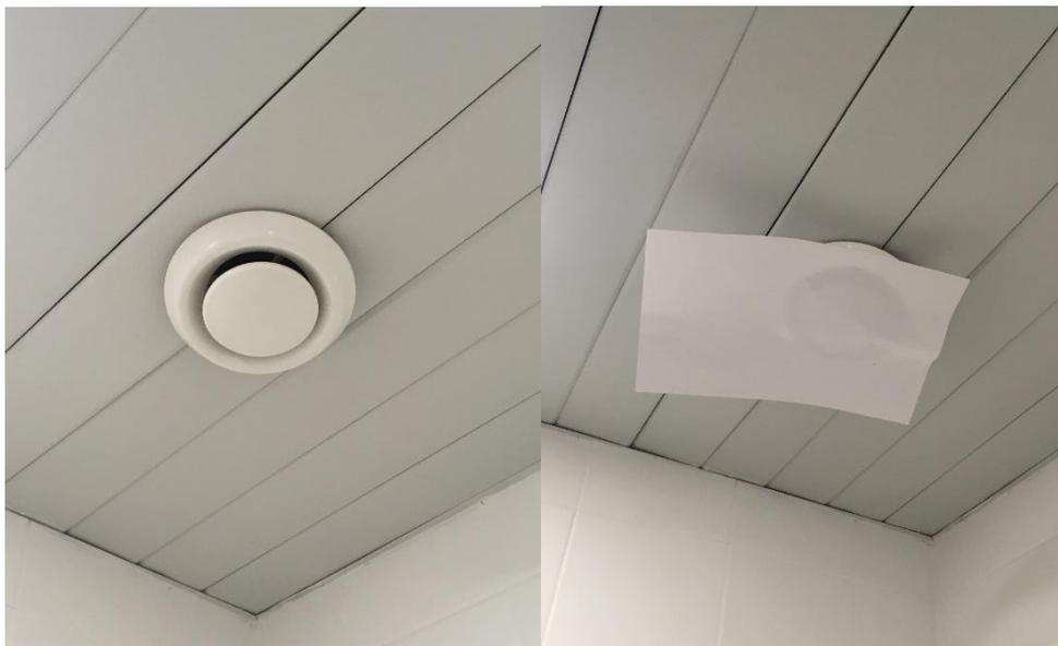
Figura 14 – Verificação de funcionamento do ventilador: extração.
