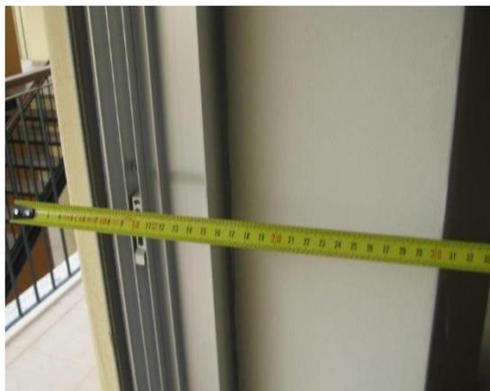
Figura 5 – Medição no local (espessura medida 30cm).
