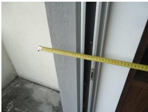
Figura 4 – Medição no local (espessura medida 35cm).
