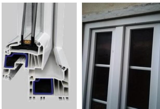
Figura 11 – Exemplo de janela com caixilho de PVC.
